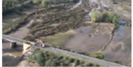
Un'immagine dei danni, il crollo di un ponte
